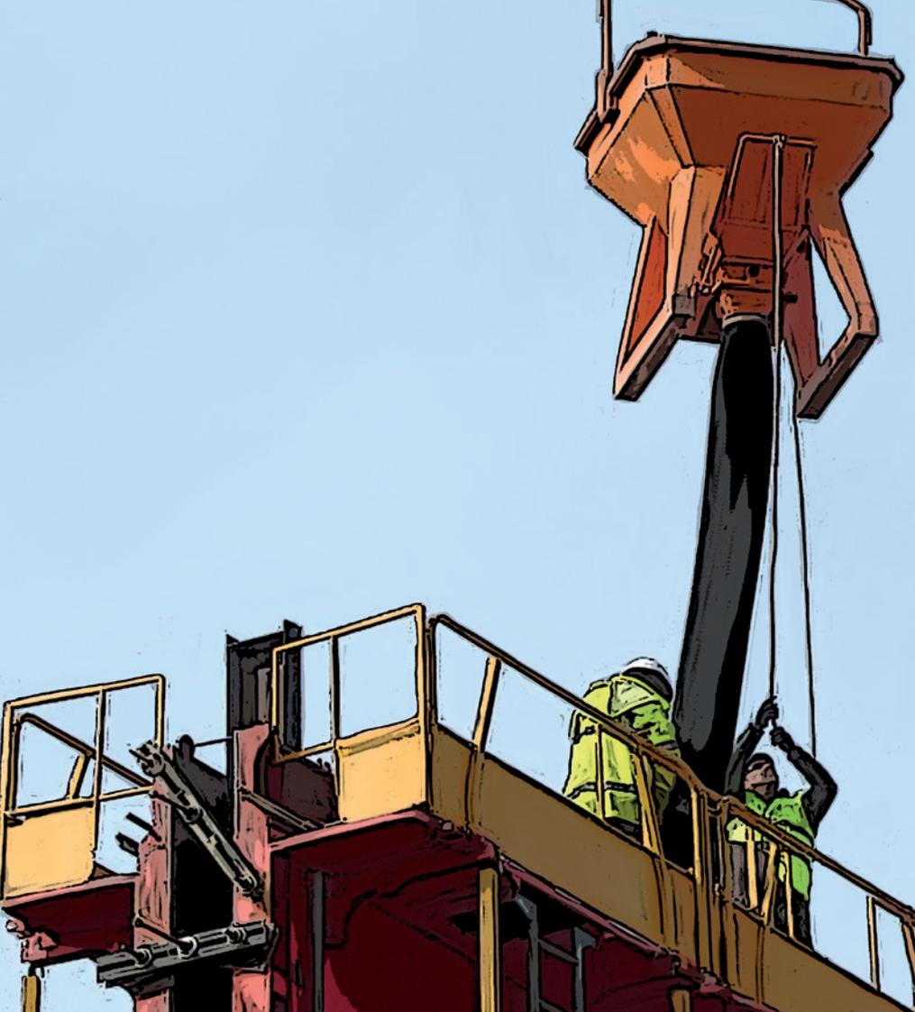
Ce tuyau à trémie sert de goulotte pour le passage du béton sur les chantiers de bâtiment et travaux publics. Léger et maniable, il permet à l'utilisateur de verser aisément le produit. La fabrication de cette goulotte sur mandrin lui permet de ne pas avoir de collage longitudinal.
